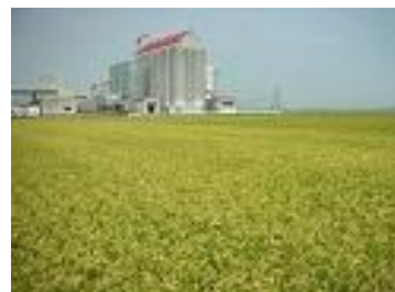
米麦等の乾燥調整施設（カントリーエレベータ）
