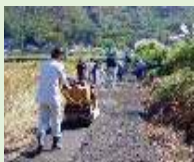
未舗装農道の舗装
