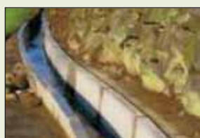
素堀り水路からの更新
