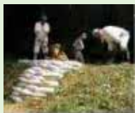
漏水箇所の補修
