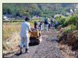
未舗装農道の舗装
