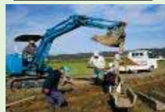
コンクリート水路の更新
