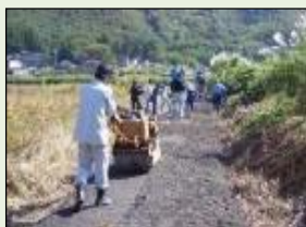
未舗装農道の舗装
