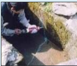
ひび割れの補修
