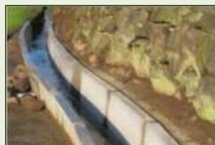
素堀り水路からの更新
