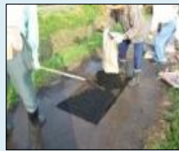
農道の部分補修
