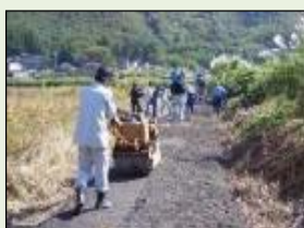
未舗装農道の舗装
