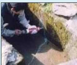
ひび割れの補修
