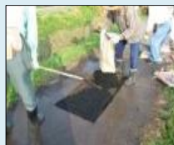
農道の部分補修
