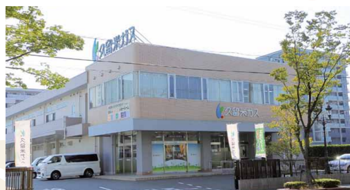
▲久留米ガス外観
