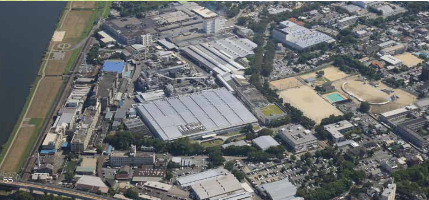
久留米工場の全景
