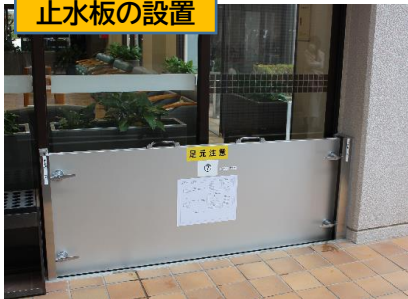
止水板の設置
