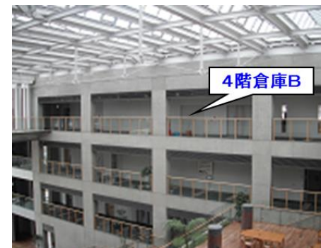
4階倉庫・機械室
