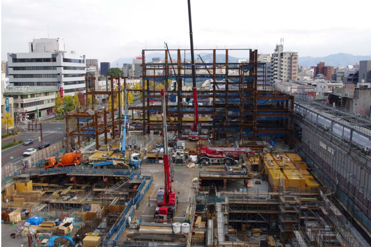
着々と工事が進む久留米シティプラザの建設現場
