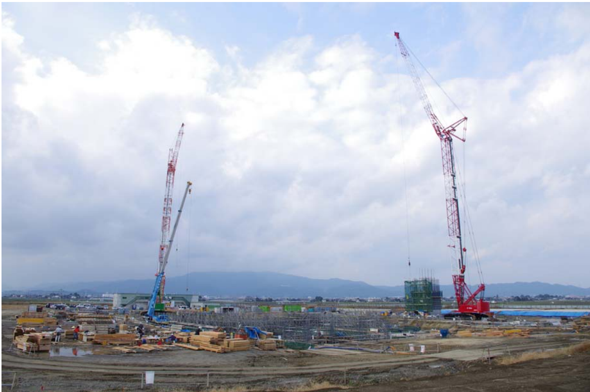
宮ノ陣町八丁島の北部一般廃棄物処理施設の工事現場
