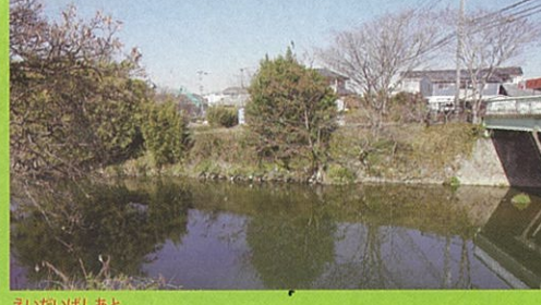
えいだいばしあと 永代橋跡 広川にかかる橋の基礎と街道の一部が残ります。
