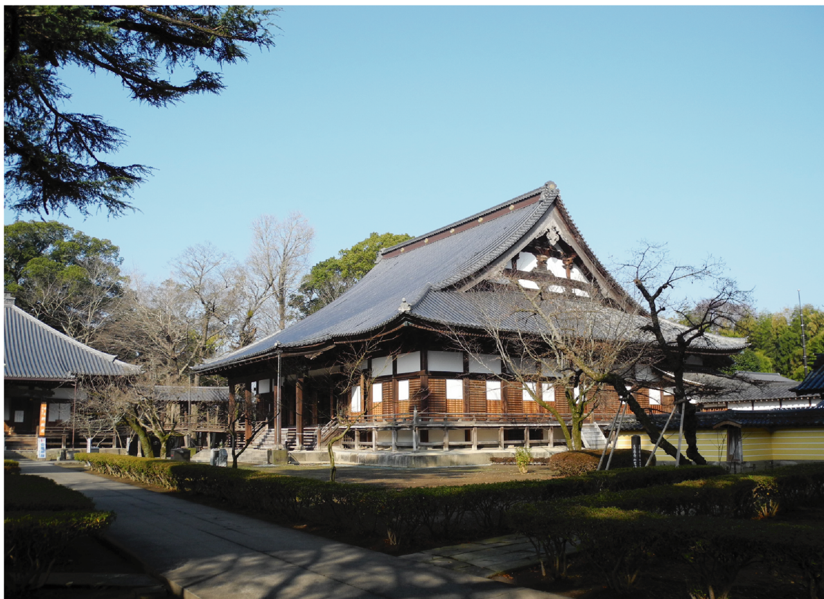
重要文化財建造物の本堂
