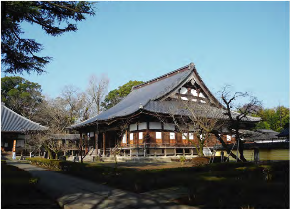
重要文化財建造物の本堂
