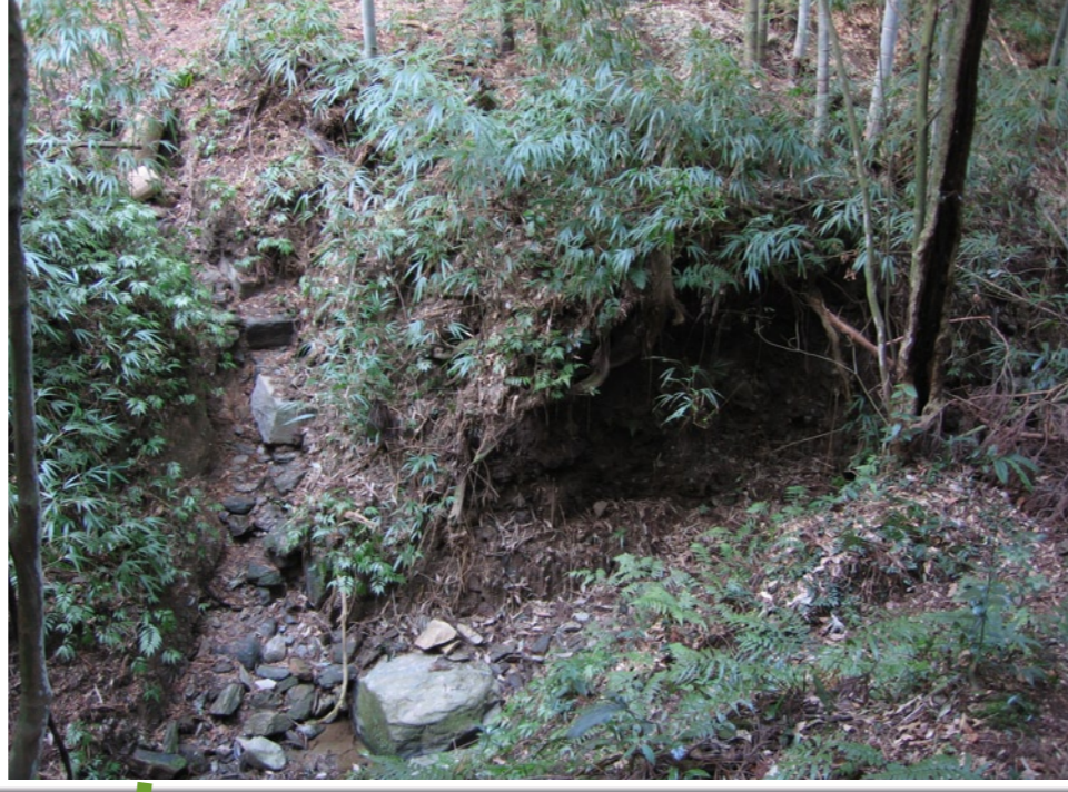
②南谷水門
