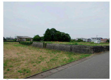
㉒Ⅱ期政庁地区：盛土と擁壁
