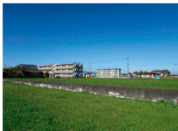
㉜国司館地区：擁壁
