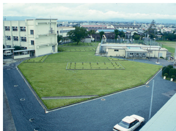
⑦Ⅳ期政庁地区：政庁域（整備後）
