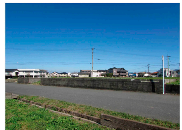
㉛国司館地区：盛土と擁壁
