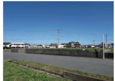
㉛国司館地区：盛土と擁壁
