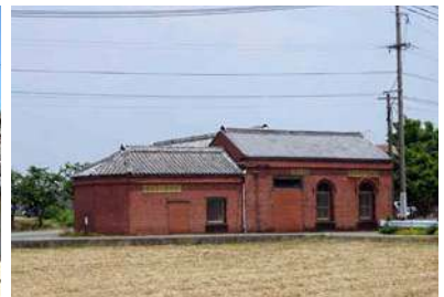
旧三井寺ポンプ所及び変電所
