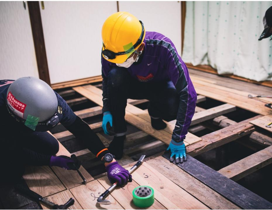
床下に入るために畳と荒板を撤去。家を傷つけないよう運び出しも慎重に
