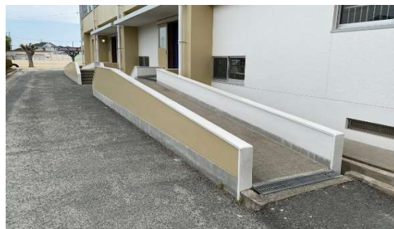
【屋内運動場のスロープ】
