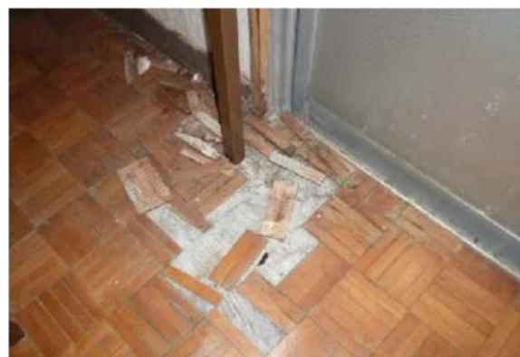
【床材破損】
