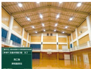
荘島体育館照明 LED 化(R4)
