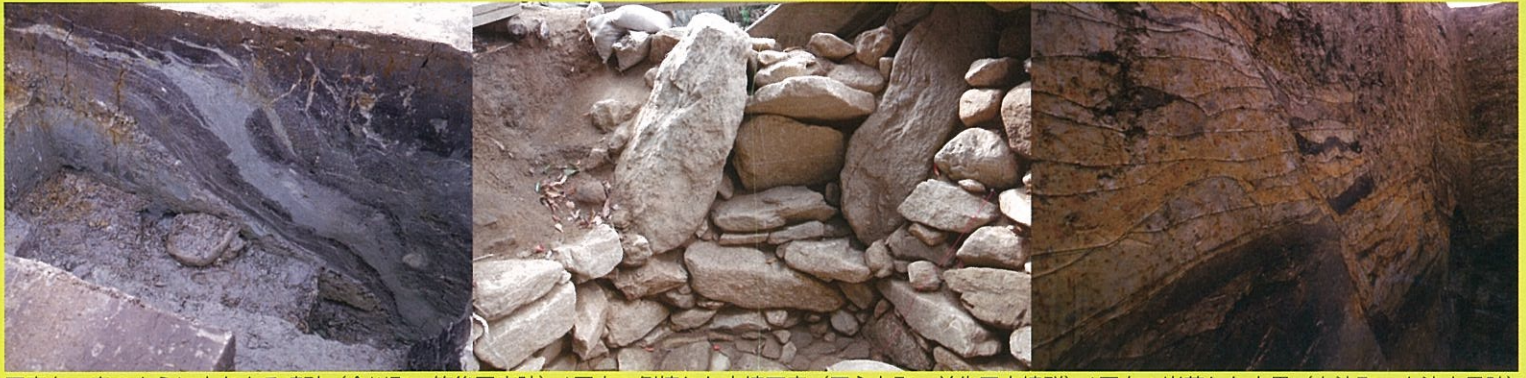
写真左：竜のように立ち上る噴砂（合川町・筑後国府跡） / 同中：倒壊した古墳石室（田主丸町・益生田古墳群） / 同右：崩落した土塁（上津町・上津土塁跡）
