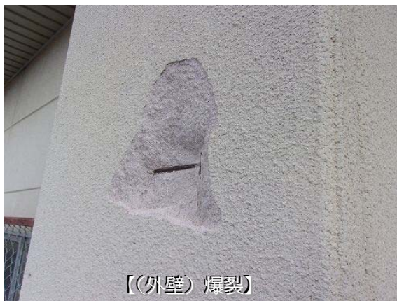
【(外壁) モルタル剥落】
