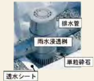
▼設置工事中の雨水浸透柵
