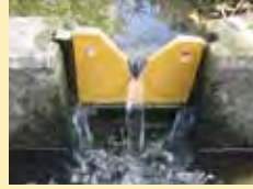
セキ板で一時的に雨水の貯留量を調整する田んぼダム
