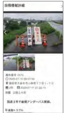
被害状況を写真で確認
