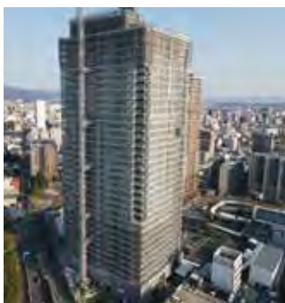
建築中の住宅棟。平成22年に完成した第一街区の住宅棟と合わせ、駅前のシンボルに
