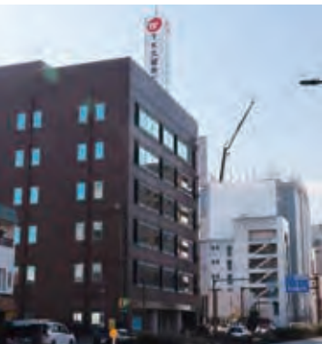
管理センターが2階に入居するビル
