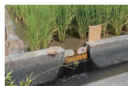
セキ板で一時的 に雨水の貯留量 を調整する田ん ぼダム
