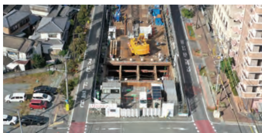
けやき通りの地下に整備が進む調節池
