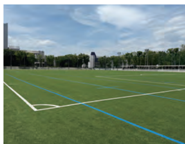
グラウンド上に水をためる 久留米大学雨水貯留施設
