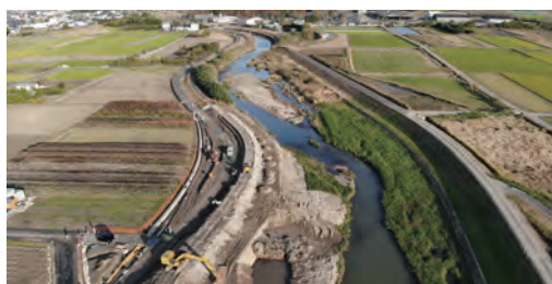
巨瀬川の堤防整備の様子
