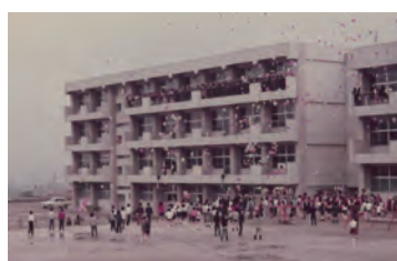
4階建て 22教室の校舎が完成しました
