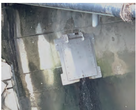
設置予定のフラップゲート。池町川流域に約40カ所設置予定
