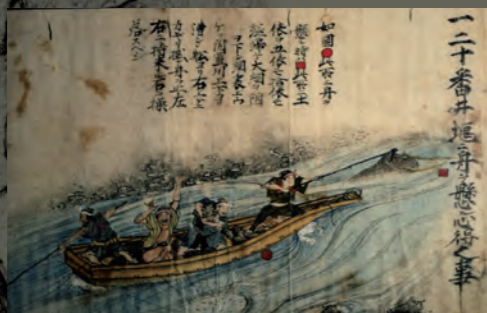
▲船をつなぎ一気に石を投げ入れる様子を描いた「床島堰築造図」。工事の心得、材木や石などの運搬の要領や器具の使い方が記されています
