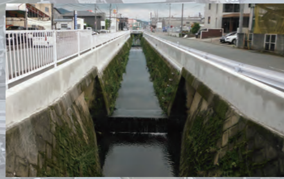
新たにコンクリート壁を作り、河川が上昇しても氾濫しないようにかさ上げをしています
