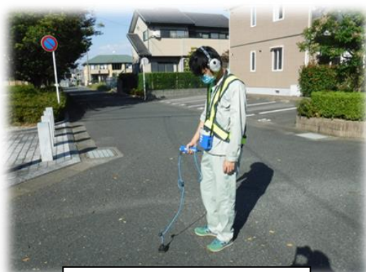
漏水調査の実施状況
