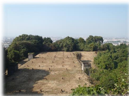
栗林配水池の構造物残存状況（上部より）
