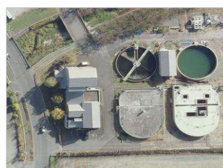
田主丸浄化センター
