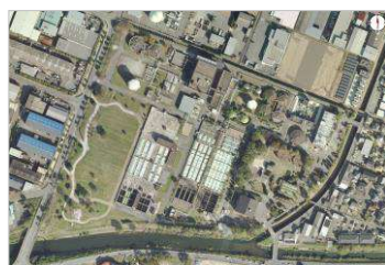
中央浄化センター
