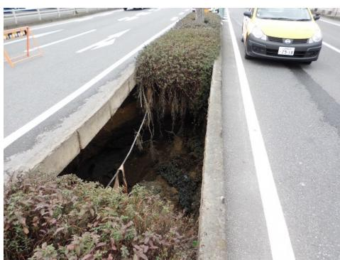
▲ 下水管路破損による道路陥没の様子【平成 24 年度 東櫛原町】
