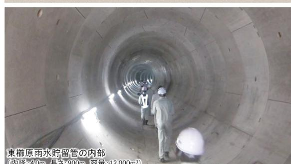
図 3-1-9 雨水施設の概要
