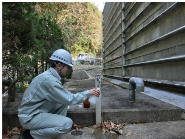
高良内配水池
