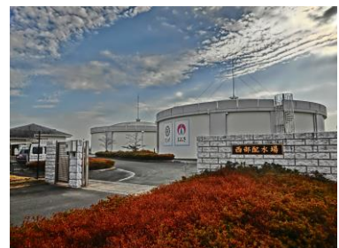
③西部配水場(配水池)
