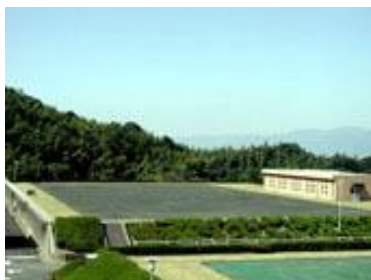
①放光寺浄水場(配水池)
