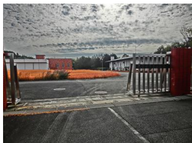
②藤山配水場(配水池)
