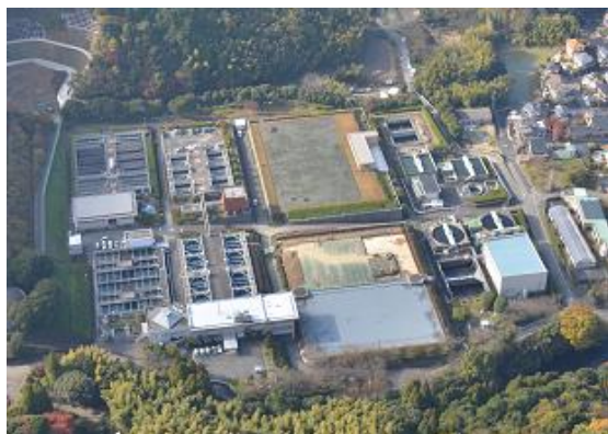
放光寺浄水場
