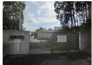
⑥石垣配水池
