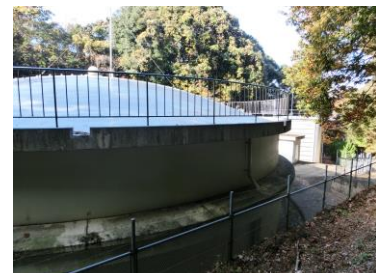
⑤高良内配水池
