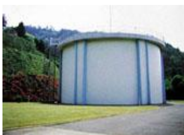
④山本配水池
