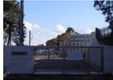
⑥石垣配水池
