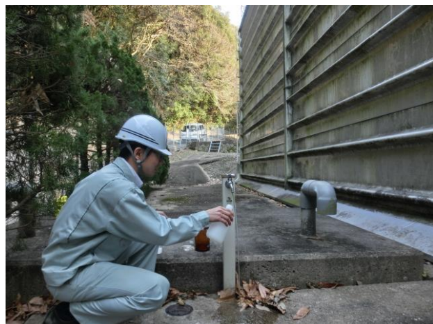
高良内配水池
