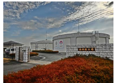
③西部配水場(配水池)
