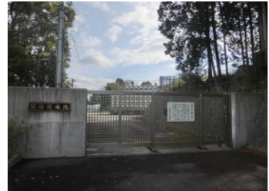
⑥石垣配水池
