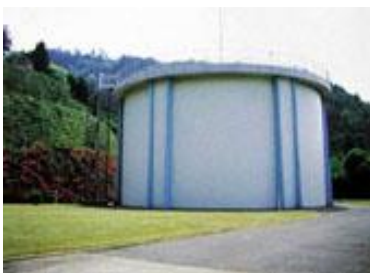
④山本配水池
