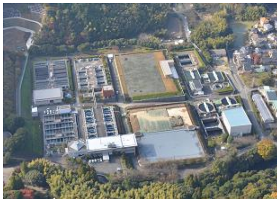
放光寺浄水場
