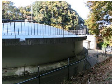
⑤高良内配水池
