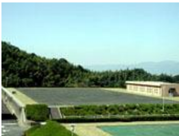
①放光寺浄水場(配水池)
