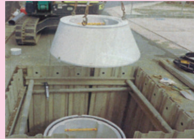
◀マンホール設置の様子
