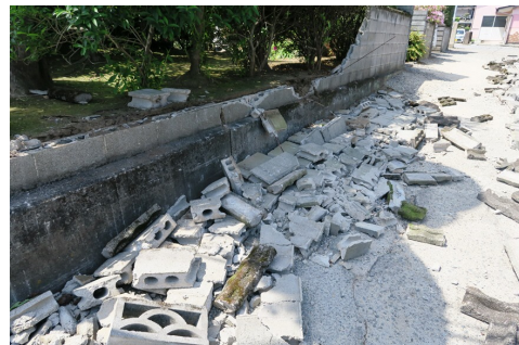
▲ 倒壊したブロック塀（防災システム研究所提供）
