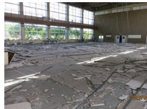
▲ 多くの体育館などの大空間で天井脱落
