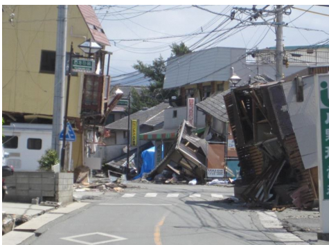
▲ 倒壊した道路沿いの住宅
