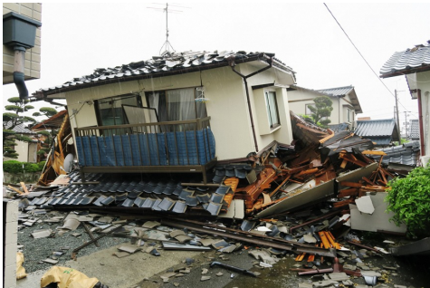
▲ 倒壊した住宅（防災システム研究所提供）
