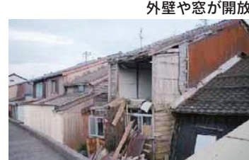
外壁や窓が開放
