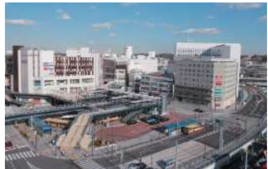
▲整備後の駅前広場
