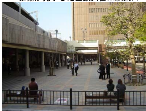
整備が完了した西鉄久留米駅東口
