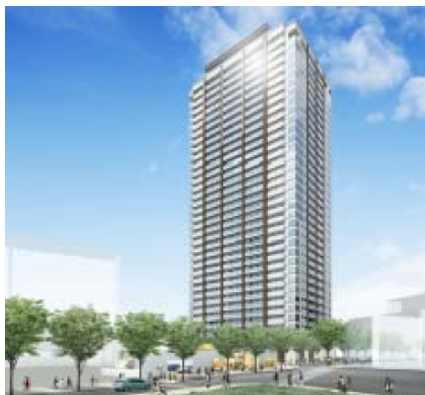
高層の集合住宅となるJR久留米駅東口の再開発ビル
