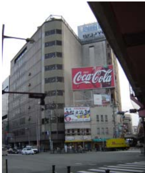
全館改装を予定している米城ビル
