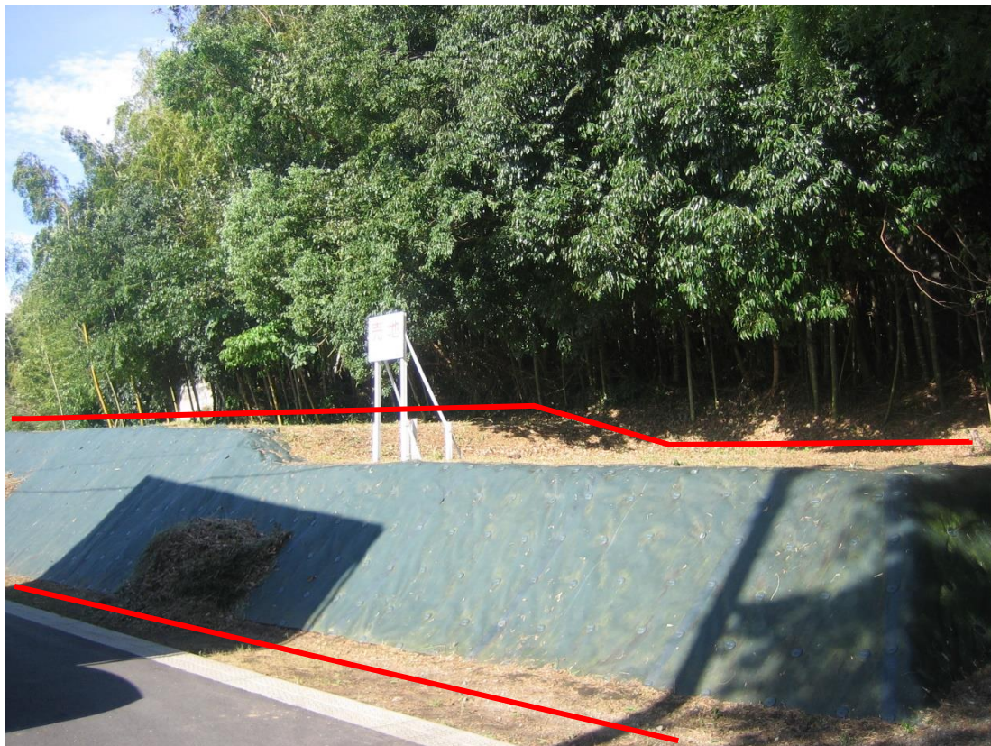
物件南側から北向きに撮影
