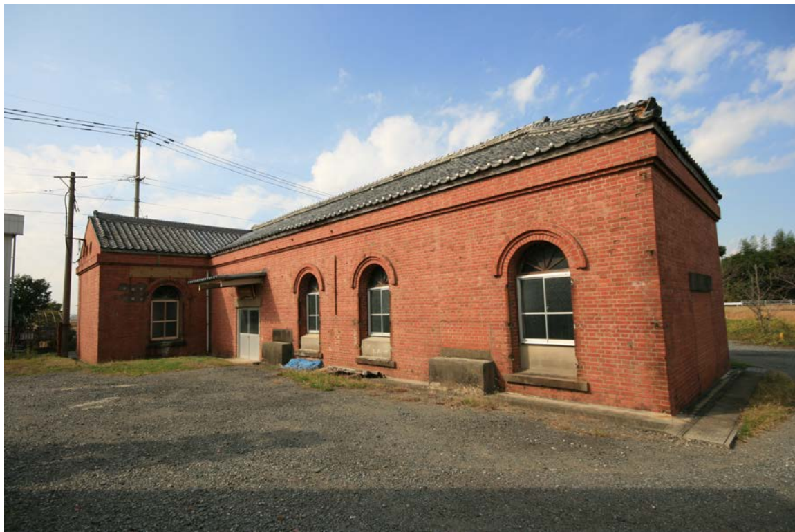
＜三井寺ポンプ場＞
