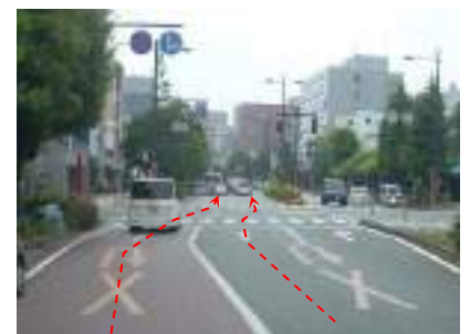
図 車線の食い違い状況
