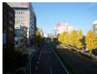
明治通り ・緑化の整備は歩道及び中央分離帯で実施され、緑量は他の区間より多い印象を受けます。樹形を大きくすることで更なる良好な環境を創出できます。
