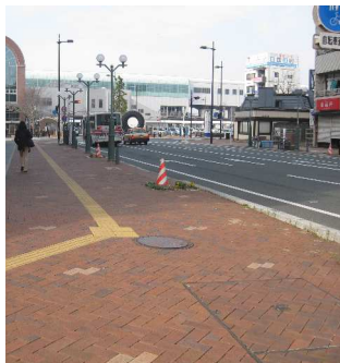
JR久留米駅前 ・インターロッキング 舗装※
