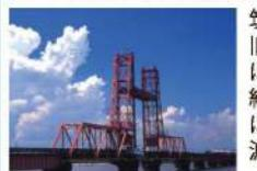
筑後川の河口にかかる旧国鉄の可動橋。全長は約507m。可動橋部は約23mまで上昇。現在は遊歩道として歩いて渡ることができます。
