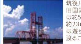
筑後川の河口にかかる旧国鉄の可動橋。全長は約507m。可動橋部は約23mまで上昇。現在は遊歩道として歩いて渡ることができます。
