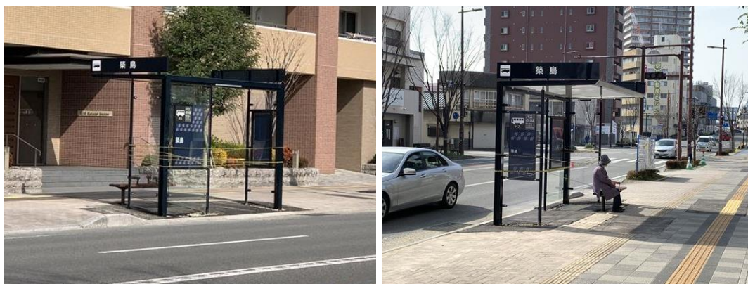
築島バス停(西鉄久留米方面)整備状況
