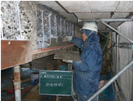
【断面修復状況】
