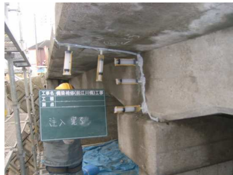
【ひび割れ補修状況】
