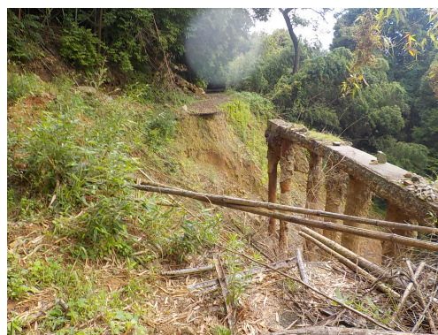
●大雨で農道が崩壊している様子
